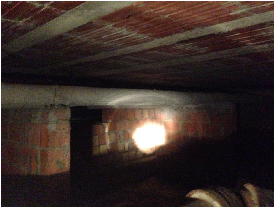
FOTO 11 Tubazioni cemento-amianto
