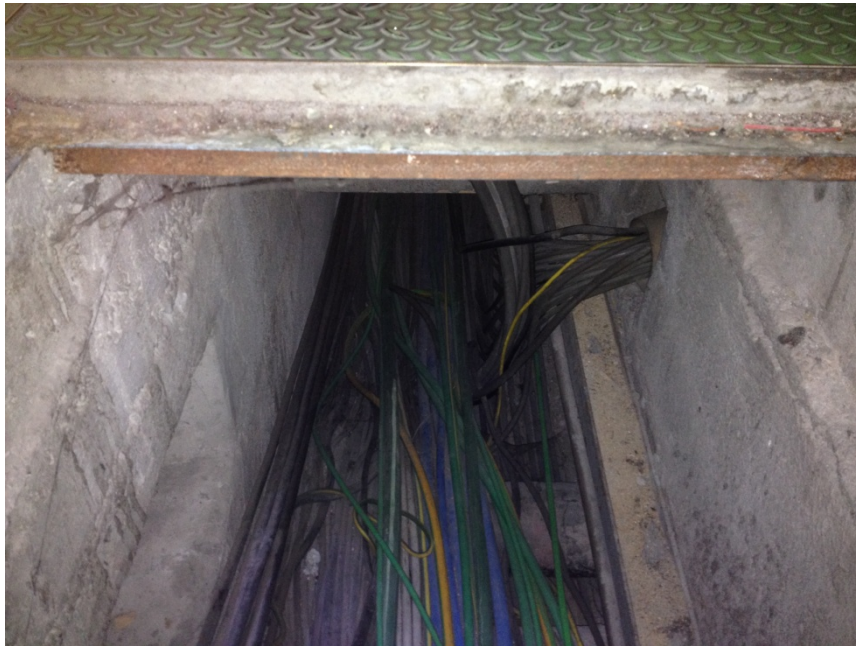
FOTO 13 Cunicolo cavi nel corridoio
