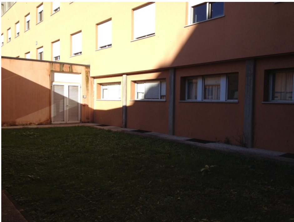
FOTO Facciata esterna
