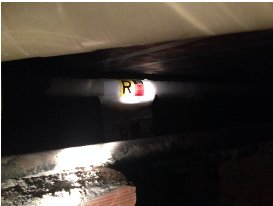
FOTO 10 Tubazioni cemento-amianto
