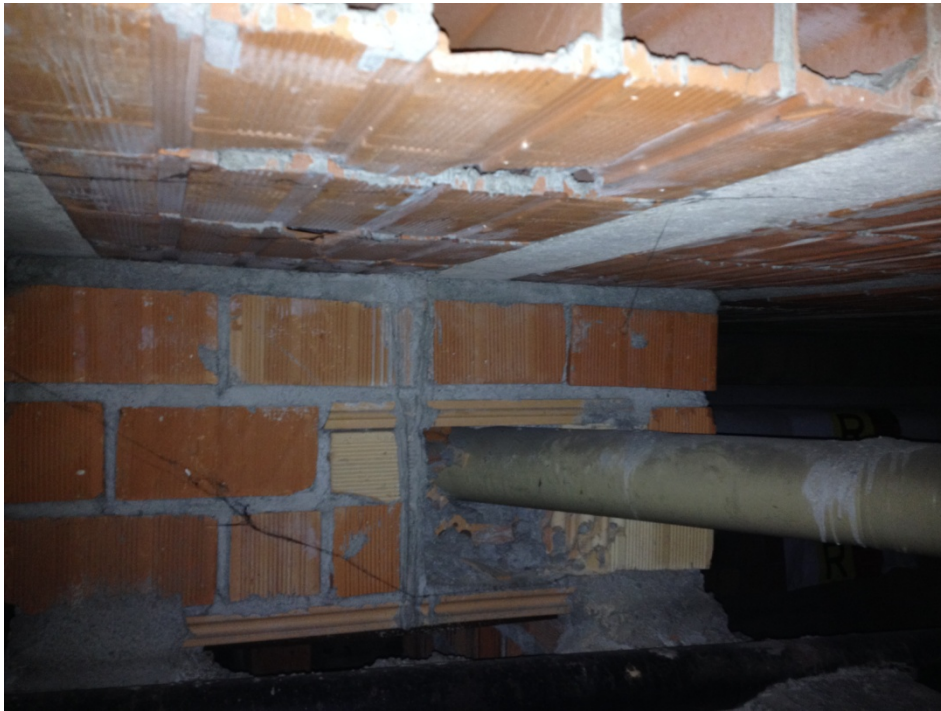
FOTO 9 Pozzetto transito linee elettriche
