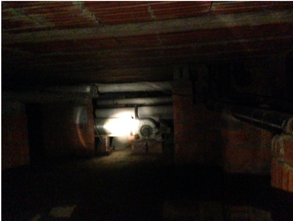
FOTO 5 Area libera per fondazione (sulla destra colonna montanti del bagno)
