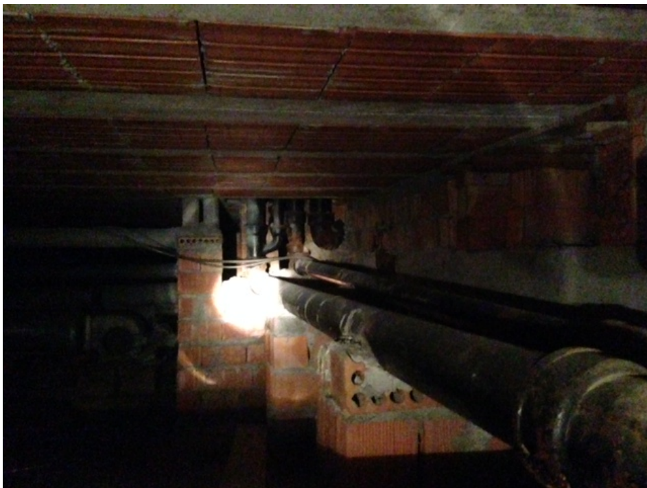
FOTO 6 Colonna montanti del bagno
